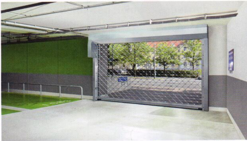
Einsatzmöglichkeit für die neue Antriebstechnik, bei Toren, wie in diesem Parkhaus.
